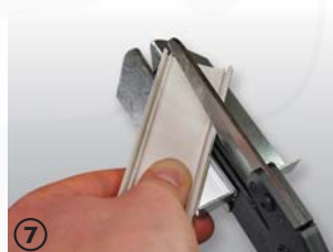
7 ustřížení úhlu 45° krytu lišty střížením podle rysky na opěrné ploše nůžek
