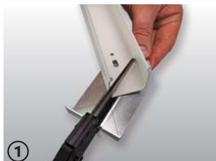
1 vyznačení úhlu 45° střížením podle rysky na opěrné ploše nůžek
